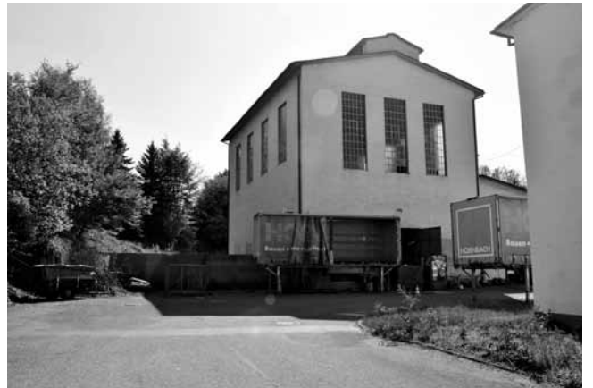
LIAS Frommern: Kesselhaus
