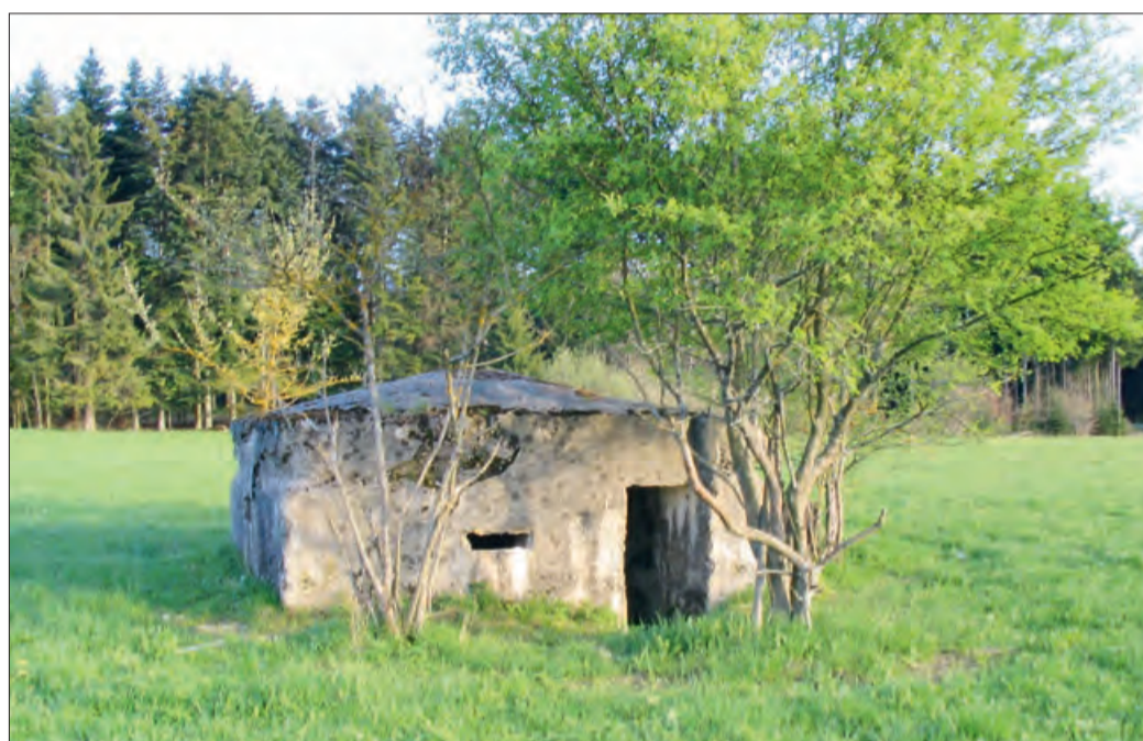
Abri antiaérien pour les gardes.
